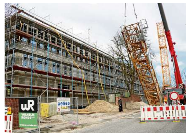
Am Neubau des Zentrums für Studium und Promotion (ZSP) wird der Kran demontiert.
